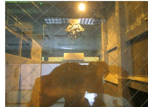
はんしゅち うんぱん クレーンで搬出口へ運搬
