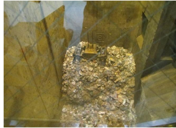
ごみピットへ入った燃えるごみを クレーンでつかむ。
